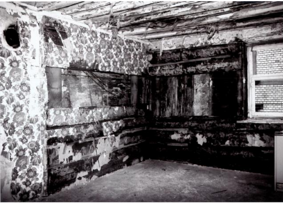
Nach der Beräumung
